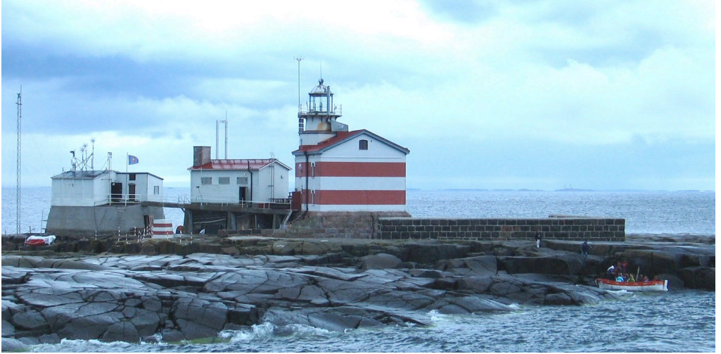
Märket ja ensimmäinen pelastusvenerekikunta laivalta rantautumassa
